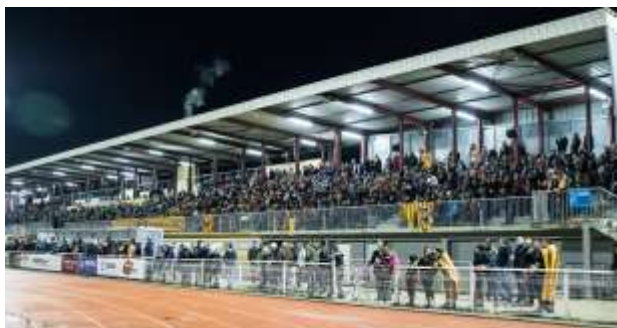
Tribune officielle pour intervention en extérieur (1 300 places assises couvertes)
